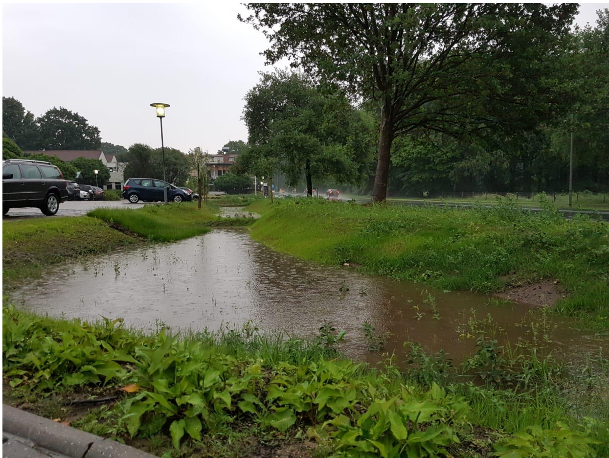
Figuur 1-4: Gerealiseerde Wadi voor afstromend water parkeerplaats en daken Hotel De Roskam
