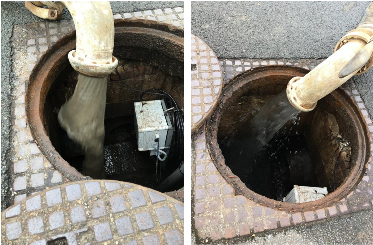
Figuur 3-26: Onttrokken water bij aanvang schoonpompen en na 10 minuten.
