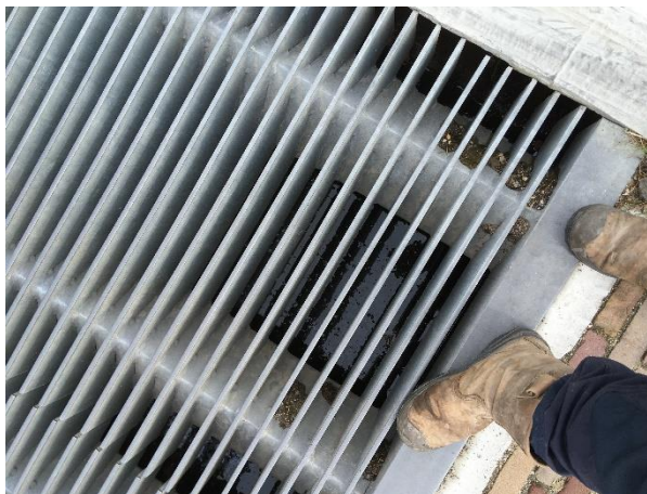
Figuur 2-2: Instroomgoten in de Arnhemsestraatweg en een instroombak met rooster aan het einde van de Lentsesteeg.
