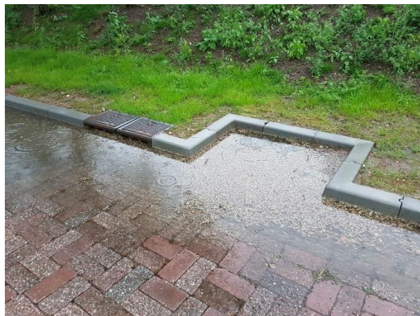
Figuur 2-2: Instroomgoten in de Arnhemsestraatweg en een instroombak met rooster aan het einde van de Lentsesteeg.
